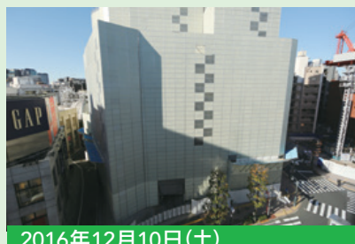
2016年12月10日(土) 解体用防音パネルの設置が完了
