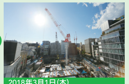
2018年3月1日(木) 新築工事が順調に進捗
