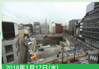
2018年1月17日(水) 既存建物の取り壊しがほぼ終了
