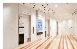
PARCO_ya店内共用通路照明の100%LED化を実現
